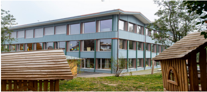
Gelungenes öffentliches Bauprojekt (Schulhaus) in Fällanden im Minergie P-Eco-Standard aus vorgefertigten Holzmodulen. Foto: PIRMIN JUNG Schweiz AG
